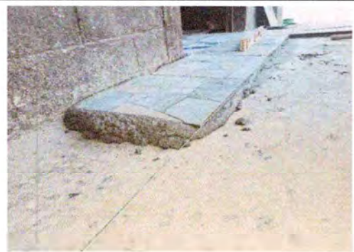
Foto 2: Sustitución de piso cerámico
