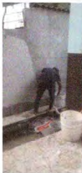
Foto 3: Sustitución de repello y cernido
