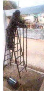
Foto 4: Reparación y mantenimiento de portón
