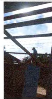
Foto 6: Sustitución de lámina troquelada y costanera
