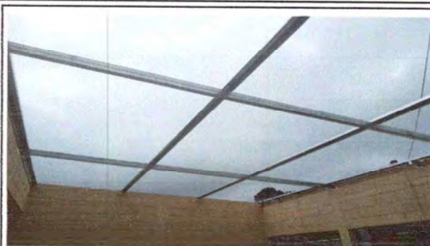
Foto 2: ESTRUCTURA DEL TECHO
