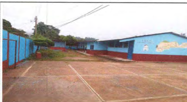
Foto 6: PINTURA EN EXTERIOR E INTERIOR
