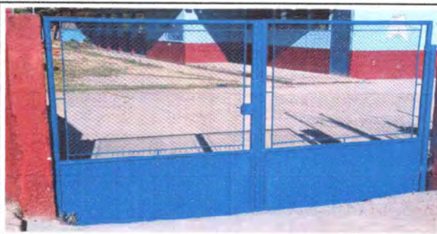
Foto 5: MANTENIMIENTO A PORTONES
