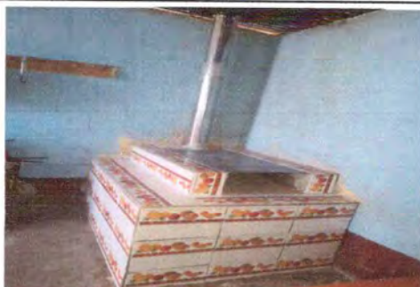
Foto 7: REPARACION O SUSTITUCION EN AREA DE COCINA
