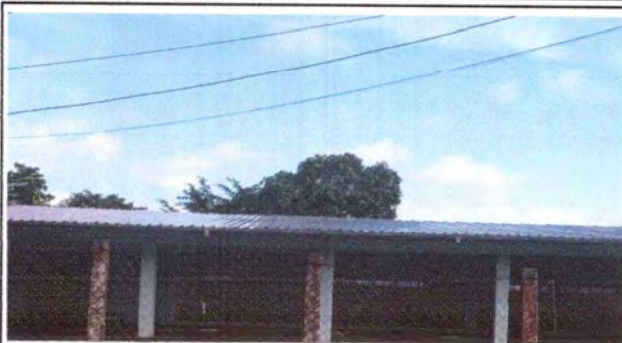
Foto 1: CUBIERTA DE TECHO
