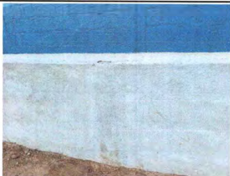
Foto 9: Reparación de muros de contención.
