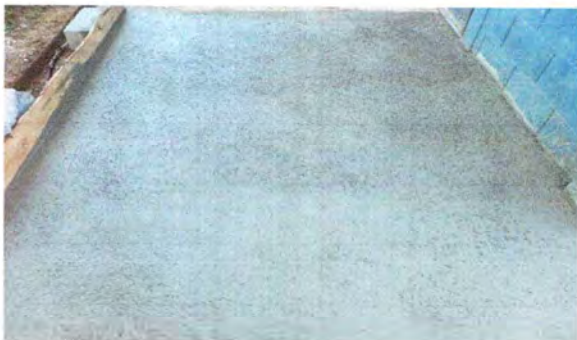
Foto 7: Losa de patio
