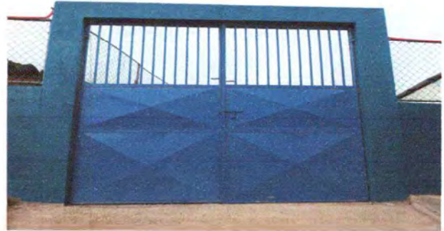
Foto 6: Mantenimiento a potones
