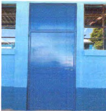
Foto 3: Reparación y mantenimiento de puertas
