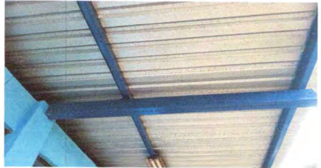
Foto 2: Estructura de techo
