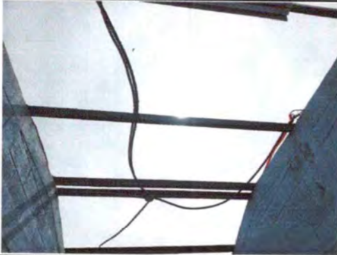
Foto1: Cubierta de lámina
