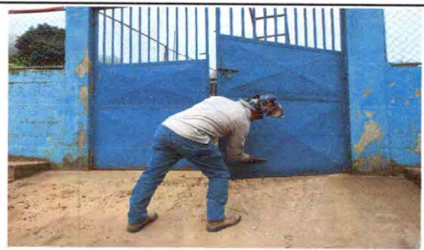
Foto 6: Mantenimiento a portones.
