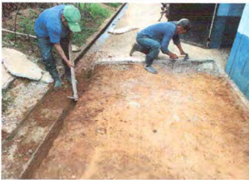
Foto7: Losa de patio
