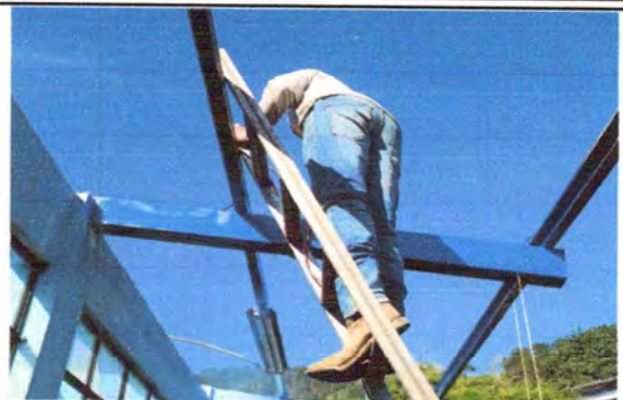
Foto 2: Estructura de techo
