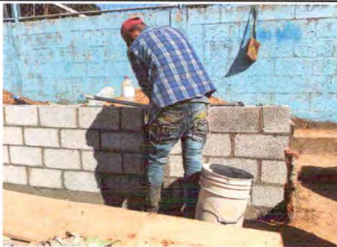
Foto 9: Reparación de muros de contención.
