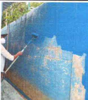
Foto 5: Pintura en muros interior y exterior
