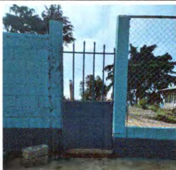
Foto 1: MANTENIMIENTO A PORTONES
