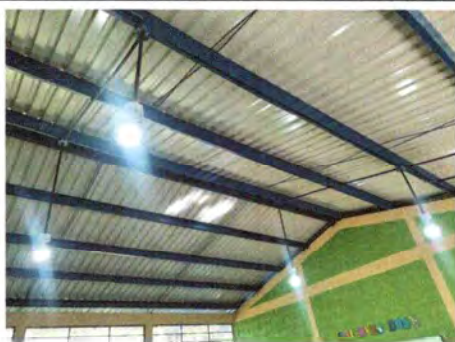
Foto 5: REPARACION SISTEMA ELECTRICO
