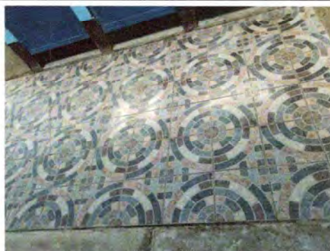
Foto 4: LOSA CORREDOR BAÑOS
