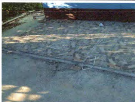
Foto 3: LOSA CORREDOR AULAS
