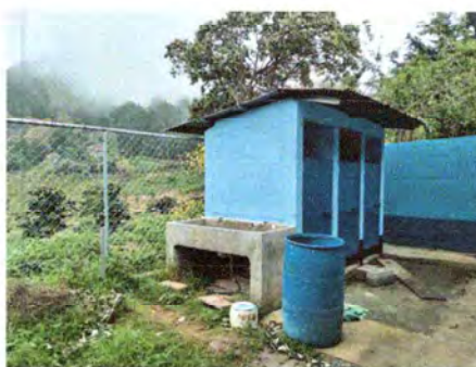
Foto 4: LOSA CORREDOR BAÑOS
