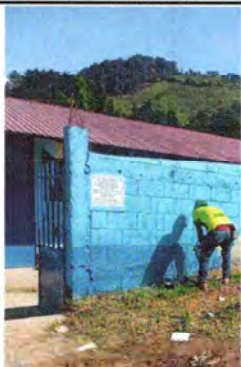
Foto1: MANTENIMIENTO A PORTONES
