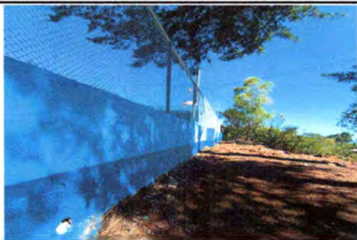
Foto1: SUSTITUCIÓN DE CERCO PERIMETRAL 75M2 MALLA LEGÍTIMA AGUJERO DE 1 PULGADA X 1.50 Y RESANADO DE MURO
