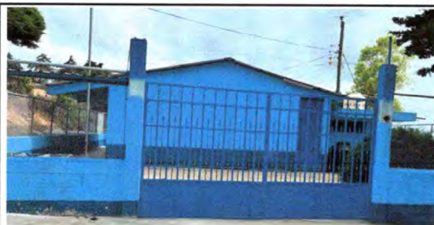
Foto 5: SUSTITUCIÓN DE PORTON DE REJA CON HIERRO LEGÍTIMO Y PROCESO 4M 2 X 2.20
