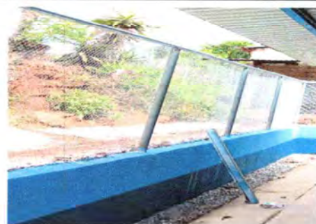
Foto 6: SUSTITUCIÓN DE CERCO PERIMETRAL 78M2
