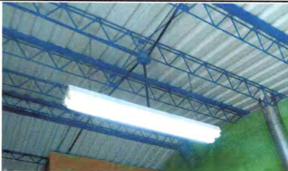
Foto 3: REVISIÓN DE Y REPARACIÓN DEL SISTEMA ELECTRICO
