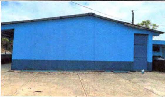
Foto1: Sustitución de pintura a base de agua.
