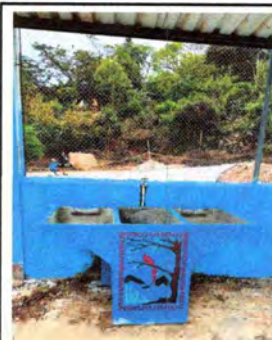
Foto 4: SUSTITUCIÓN DE 2 PILAS
