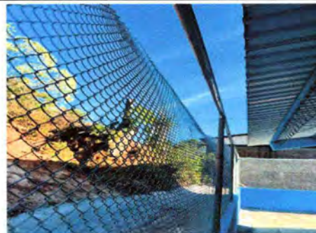
Foto 4: Malla 75 metros lineales con rezanado de muro
