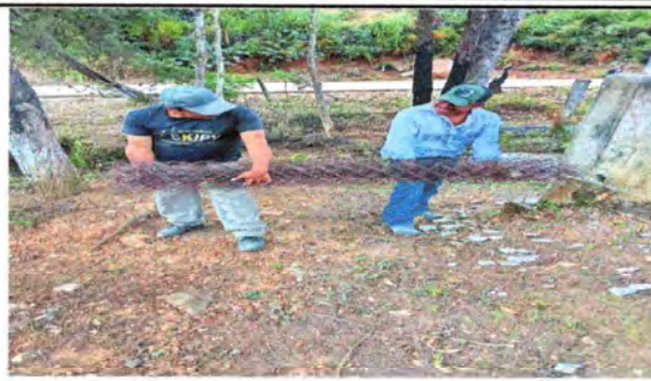
Foto 2: SUSTITUCIÓN DE MALLA
