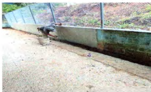
Foto 3: Cerco perimetral cambio de malla y rezanado
