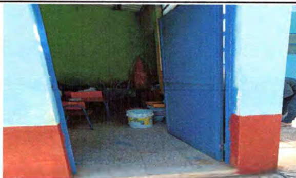
Foto 3: SUSTITUCIÓN DE PINTURA AULAS
