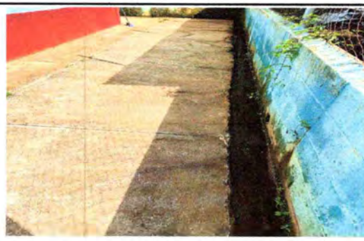
Foto 4: SUSTITUCIÓN DE CUNETA DE CONCRETO (CUNETA FRANCESA)
