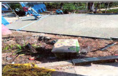
Foto 5: LOSA INGRESO AL PATIO
