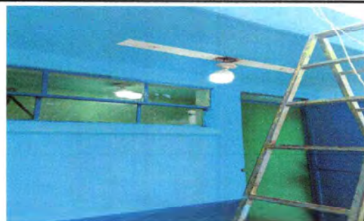
Foto 5: Revisión y reparación sistema eléctrico
