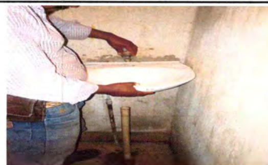
Foto 6: REPARACIÓN Y MANTENIMIENTO LAVAMANOS
