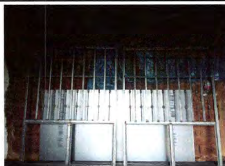
Foto 2: Sustitución de Portón de reja con hierro legítimo y proceso 4 M2 X 2.20
