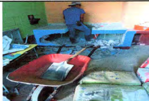
Foto 6: SUSTITUCIÓN DE PILA
