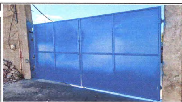
FOTO 4. REPARACION Y MANTENIMIENTO DE PORTON ENTRADA PRINCIPAL.
