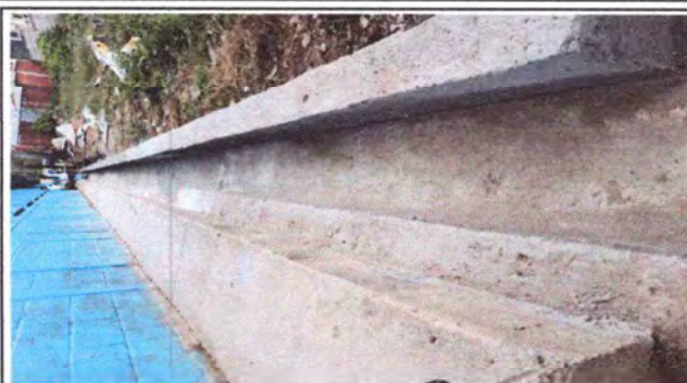
FOTO 2. REPARACION Y MANTENIMIENTO DE CUNETA.
