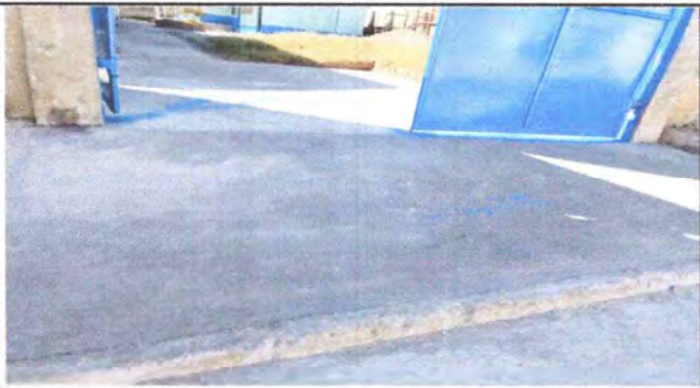
FOTO 7. CAMBIO Y REPARACION DE LOSA DE PATIO.
