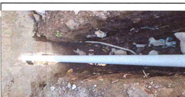
FOTO 6. REPARACION Y MANTENIMIENTO DE DRENAJE.
