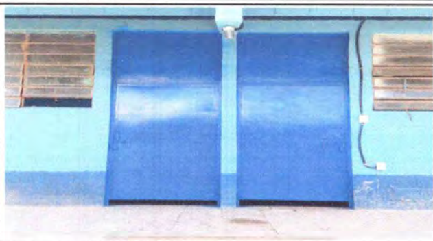
FOTO 1. REPARACION Y MANTENIMIENTO DE PUERTAS.
