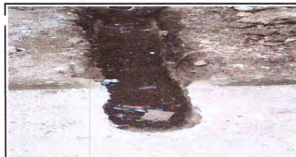
Foto 6: REPARACIÓN Y MANTENIMIENTO DE DRENAJE
