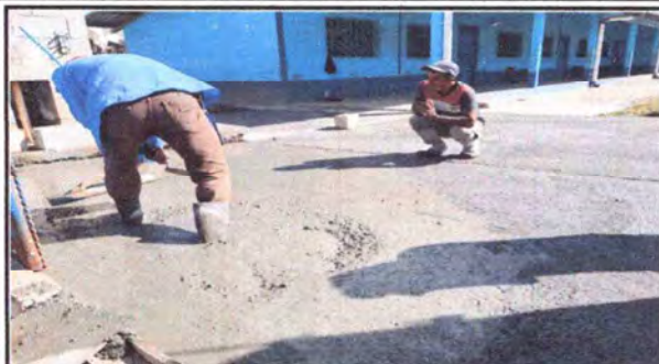
FOTO 7. CAMBIO Y REPARACIÓN DE LOSA DE PATIO.
