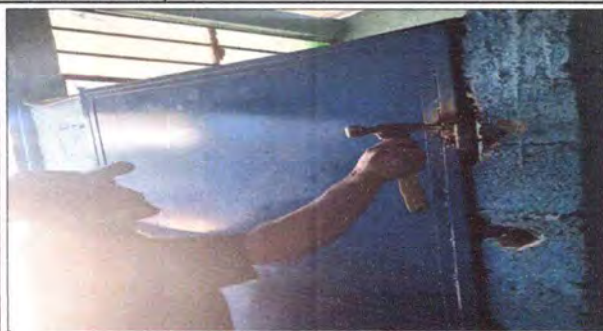
Foto 1: REPARACION Y MANTENIMIENTO DE PUERTAS.
