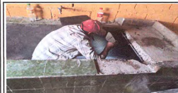
Foto 5: SUSTITUCIÓN DE AZULEJO EN TANQUE DE LA COCINA.
