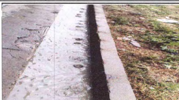
Foto 2: REPARACIÓN Y MANTENIMIENTO DE CUNETA.
