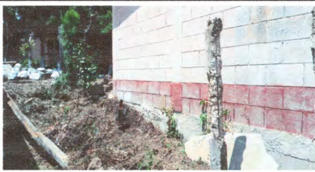
Foto 2: Cerco de muro
