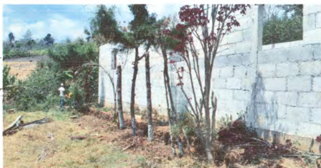
Foto 3: Cerco de Muro
