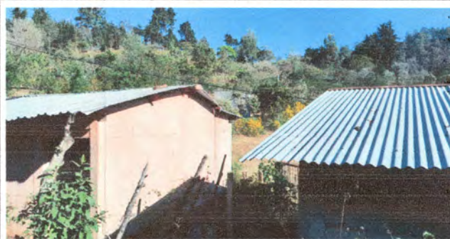
Foto 2: Cubierta de Lamina.
