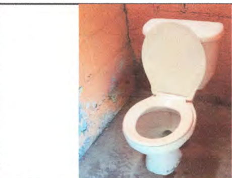
Foto 3: Reparación de Sanitario.
