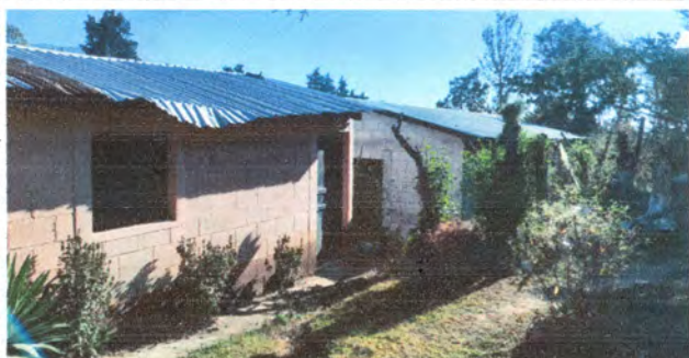
Foto1: Cubierta de Lamina.
