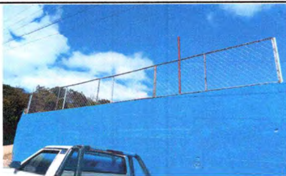
Foto 1: SUSTITUCIÓN DE CERCO MURO PERIMETRAL BLOCK Y MALLA
