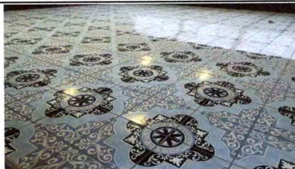
Foto 4: REPARACIÓN Y SUSTITUCIÓN DE AZULEJO
