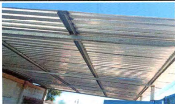
Foto1: CUBIERTA DE LÁMINA
