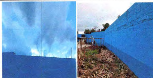
Foto 2: PINTURA DE MURO PERIMETRAL EXTERIO E INTERIOR A BASE DE ACEITE
