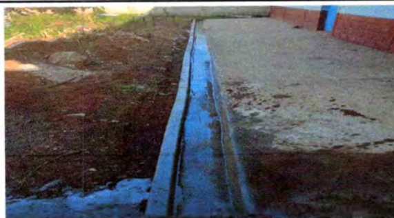
Foto 6: CUNETA DE CONCRETO
