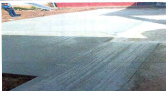
Foto 5: LOSA DE PATIO
