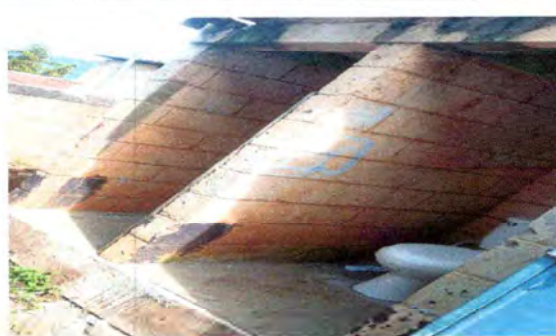
Foto 4: SUSTITUCIÓN DE PUERTAS ÁREA DE BAÑOS
