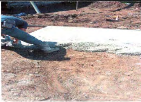
Foto1: LOSA DE PATIO
