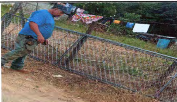
Foto 5: SUSTITUCIÓN DE CERCO MURO PERIMETRAL BLOCK Y MALLA
