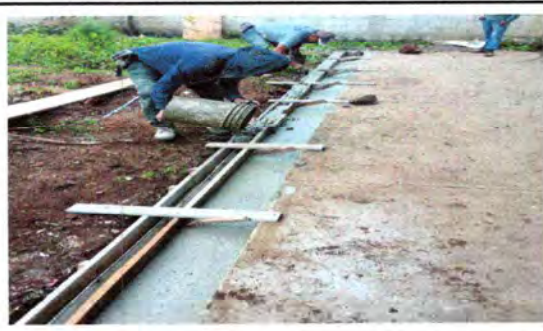
Foto 6: REPARACIÓN Y MANTENIMIENTO CUNETA DE CONCRETO
