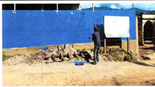
Foto 2: SUSTITUCIÓN DE PINTURA A BASE DE ACEITE MURO PERIMETRAL
