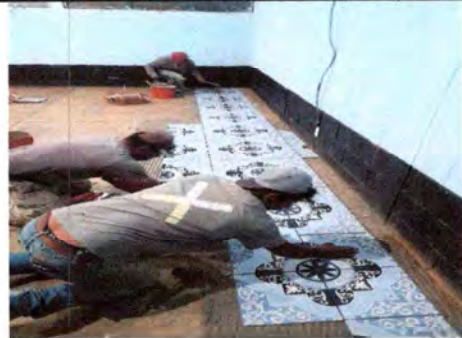
Foto 2: REPARACIÓN O SUSTITUCIÓN DE AZULEJO
