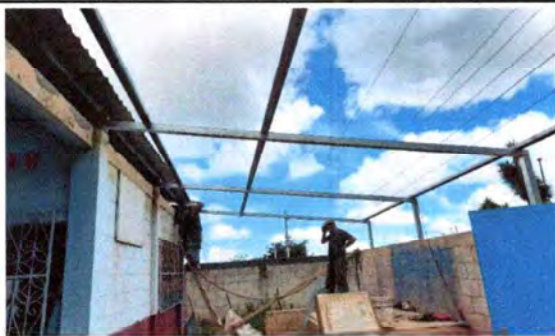
Foto1: CUBIERTA DE LAMINA
