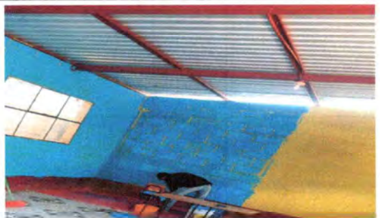
Foto 3: SUSTITUCIÓN DE PINTURA A BASE DE AGUA
