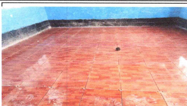
Foto 2: SUSTITUCION DE PISO
