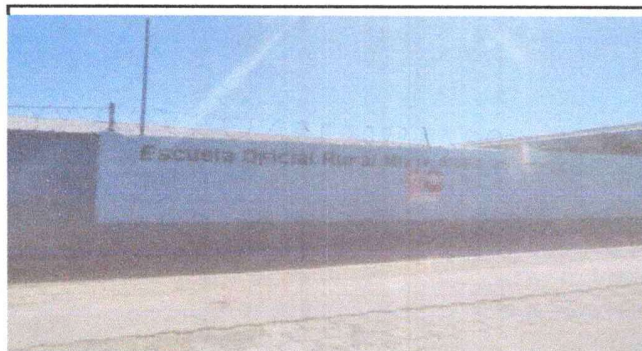
Foto 3: PINTURA DE MUROS INTERIOR Y EXTERIOR
