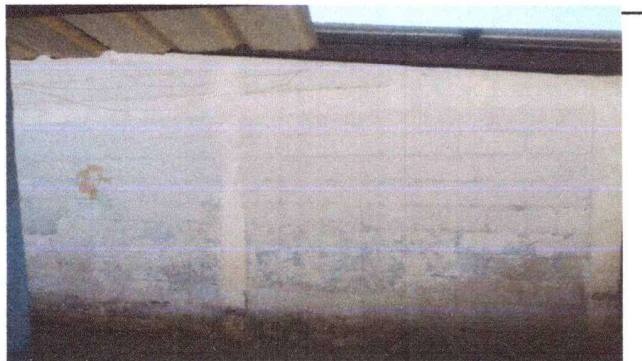
Foto 3: PINTURA DE MUROS INTERIOR Y EXTERIOR
