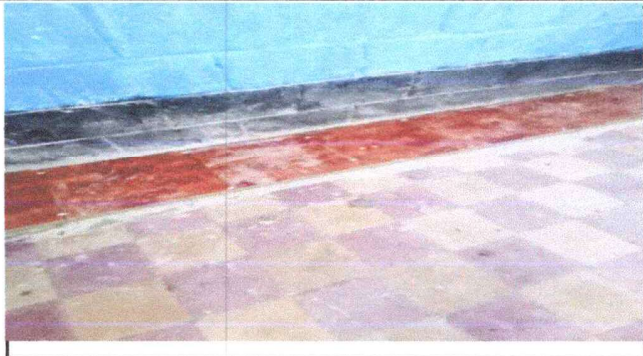
Foto 2: SUSTITUCION DE PISO
