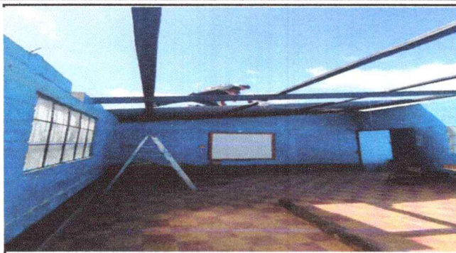
Foto1: CUBIERTA DE LAMINA
