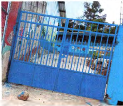
Foto 1: SUSTITUCIÓN DE PORTÓN DE REJAS CON HIERRO LEGÍTIMO Y PROCESO DE 3 M2 X 2.20
