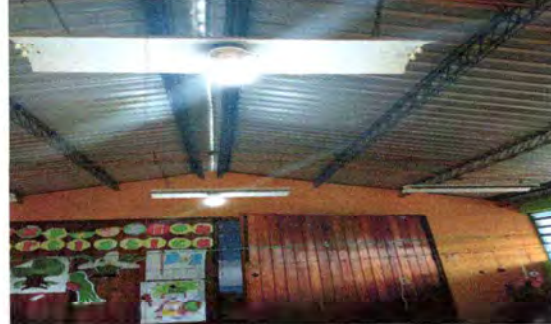
Foto 4: REPARACIÓN Y REVISIÓN DEL SISTEMA ELÉCTRICO
