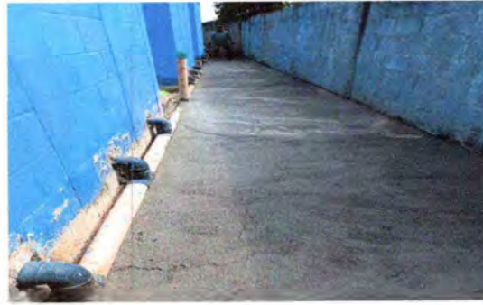
Foto 2: REPARACIÓN DE DRENAJES
