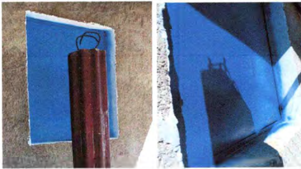
Foto 1: REPARACIÓN Y MANTENIMIENTO VENTANAS COCINA
