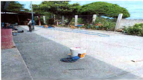
Foto 3: SUSTITUCIÓN DE LOSA DE PATIO INCLUIDO BASE, FUNDICIÓN Y ACABADO
