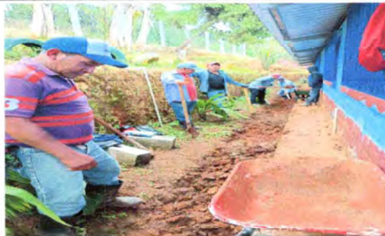
Foto 2: SUSTITUCIÓN DE CUNETA DE CONCRETO
