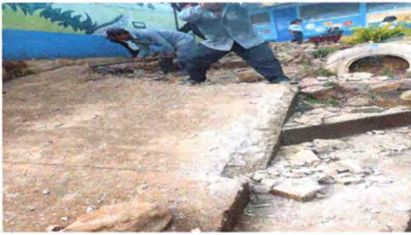
Foto1: LOSA DE PATIO
