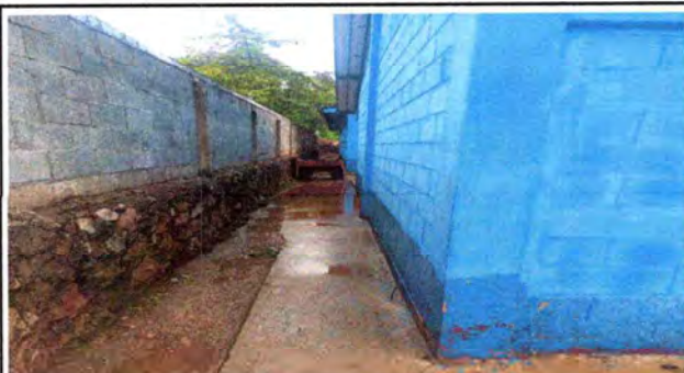
Foto 4: SUSTITUCIÓN DE CUNETA
