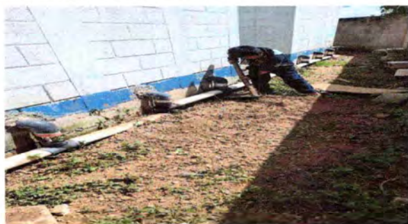
Foto 3: REPARACIÓN DE DRENAJE
