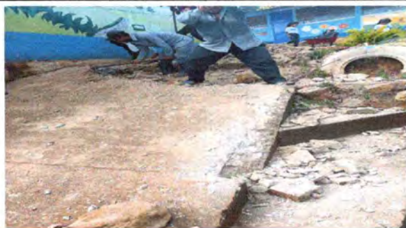
Foto1: LOSA DE PATIO
