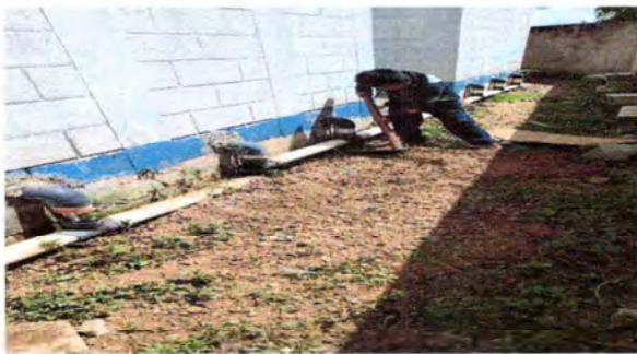
Foto 3: REPARACIÓN DE DRENAJE
