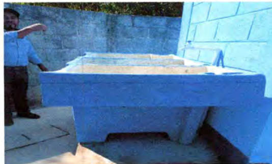
Foto 4: INSTALACIÓN DE UNA PILA
