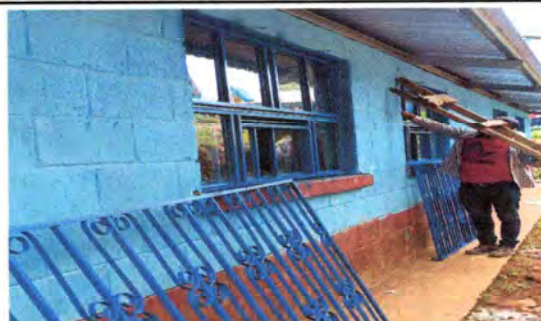
Foto 5: SUSTITUCIÓN DE VENTANALES
