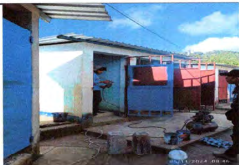
Foto 3: PINTURA PUERTA DE BAÑOS
