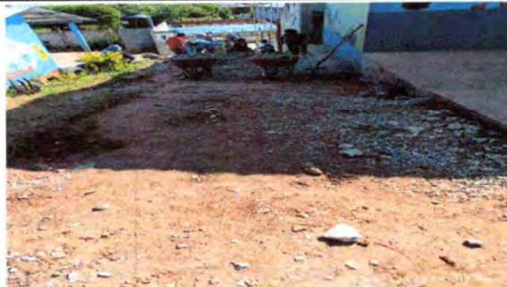
Foto 6: SUSTITUCIÓN LOSA DE PATIO
