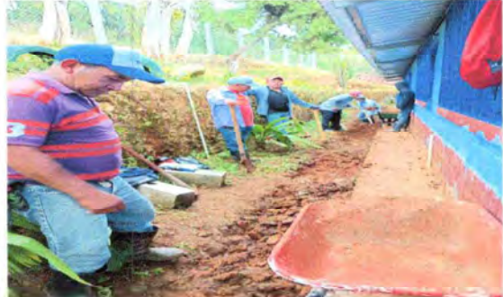
Foto 2: SUSTITUCIÓN DE CUNETA DE CONCRETO
