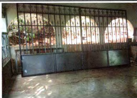
Foto 1: SUSTITUCIÓN PORTÓN DE REJA DE 3M2 X 2.20
