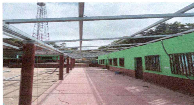
Foto 2: Estructura de techo
