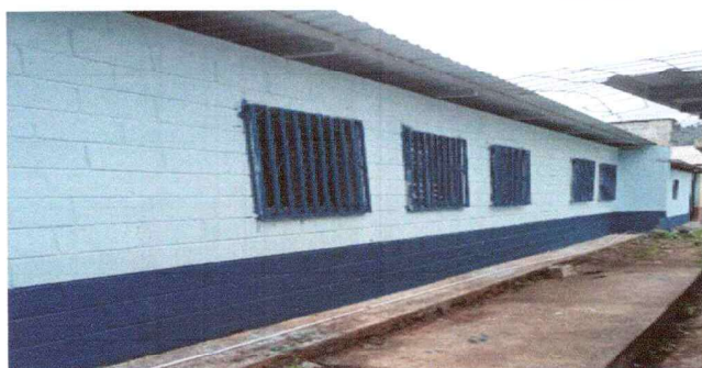
Foto 5: Pintura de muro, interior y exterior
