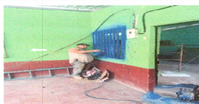
Foto 4: Reparacion de Ventanas
