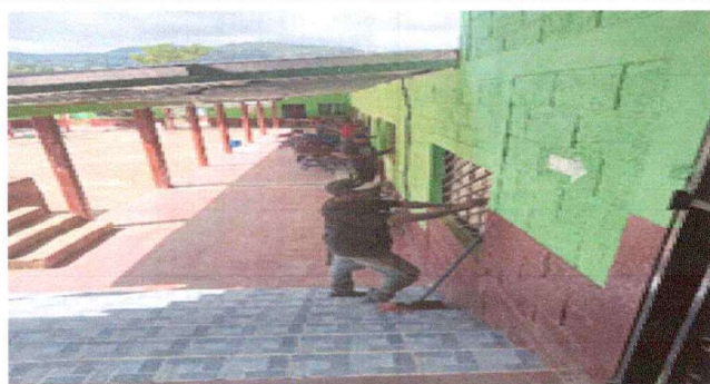
Foto 3: Reparacion de puertas
