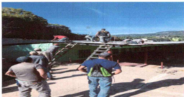
Foto1: Cubierta de lámina
