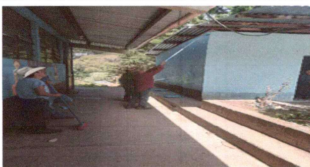
Foto 5: Pintura de muros interior y exterior
