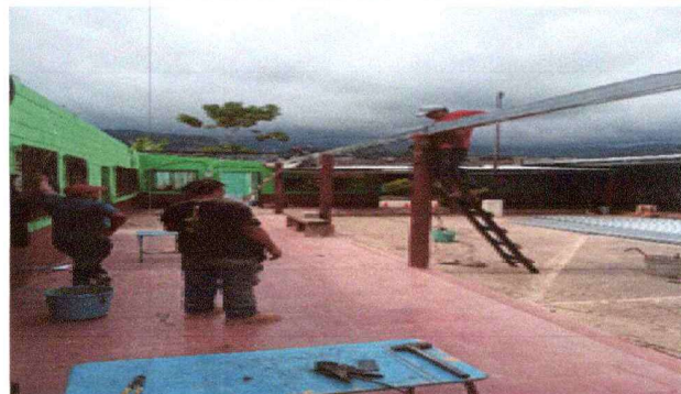
Foto 2: Estructura de techo
