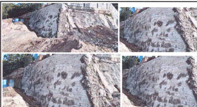
Foto 2: CONSTRUCCION DE UN MURO CICLOPEO DE MEDIDAS DE 6 DE LARGO Y ALTO 5 METROS
