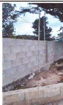
Foto 1.2: SE SUSTITUIRA LA MALLA Y SE COLOCARA MALLA A 35 METROS LINEALES CON UNA ALTURA DE 1 METRO DE MALLA CON TUBO DE 2 PULGADAS.
