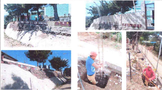
Foto 1.1: SE CONSTRUIRA UN MURO DE BLOCK DE 1 METRO DE ALTO QUE LLEVARA ZAPATAS, COLUMNAS, VIGAS INTERMEDIAS Y VIGA DE REMATE Y TENDRA UNA LONGITUD DE 35 METROS LINEALES Y DE
