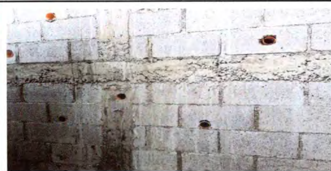
Foto 5: CERCO O MURO PERIMENTRAL
