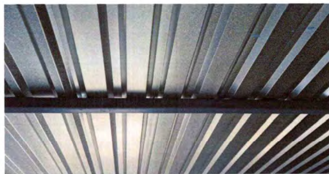
Foto 3: ESTRUCTURA DE TECHO
