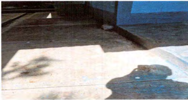
Foto1: LOSA DE PATIO
