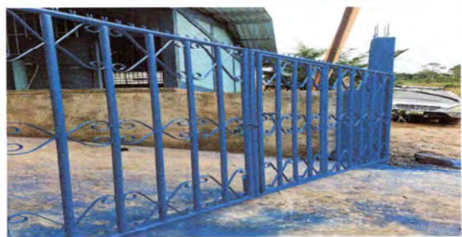
Foto 5: MANTENIMIENTO A PORTONES
