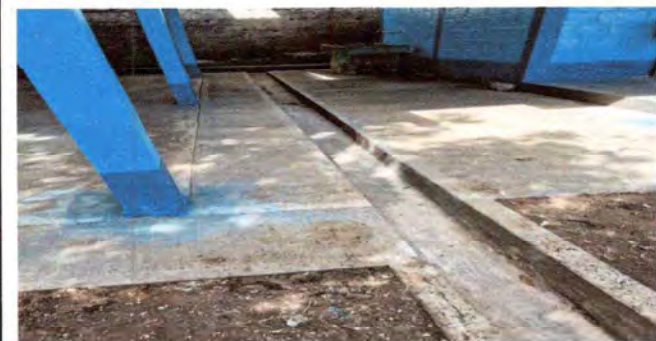
Foto 6: CUNETA DE CONCRETO
