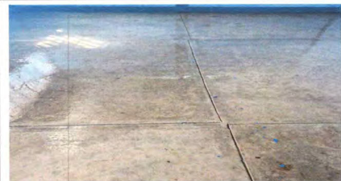
Foto 4: PISO (FUNDICION DE CONCRETO)
