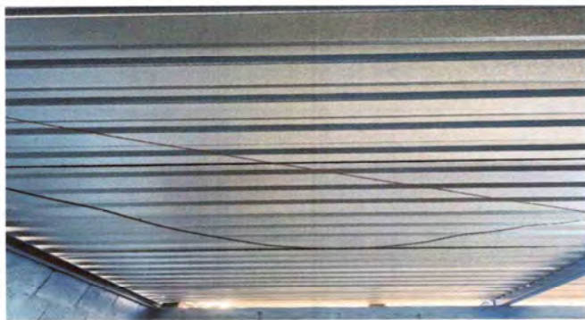
Foto1: CUBIERTA DE LAMINA
