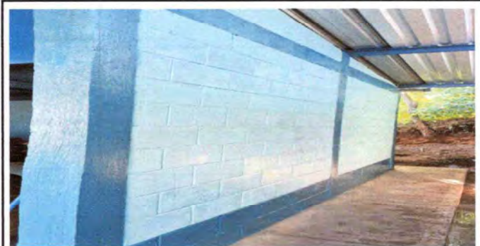
Foto 4: PINTURA EN MUROS INTERIOR Y EXTERIOR
