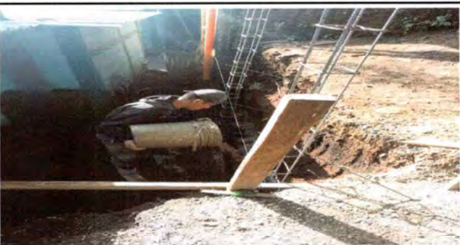
Foto 5: CERCO O MURO PERIMENTRAL
