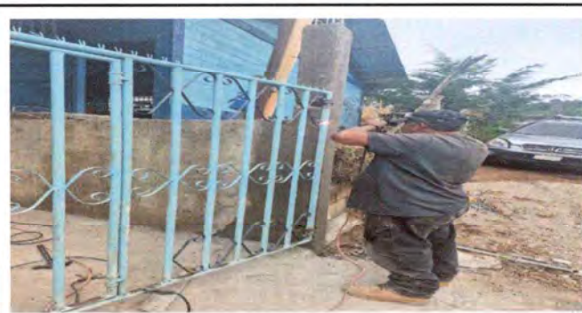
Foto 5: MANTENIMIENTO A PORTONES
