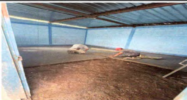
Foto 4: PISO (FUNDICION TORTA DE CONCRETO)
