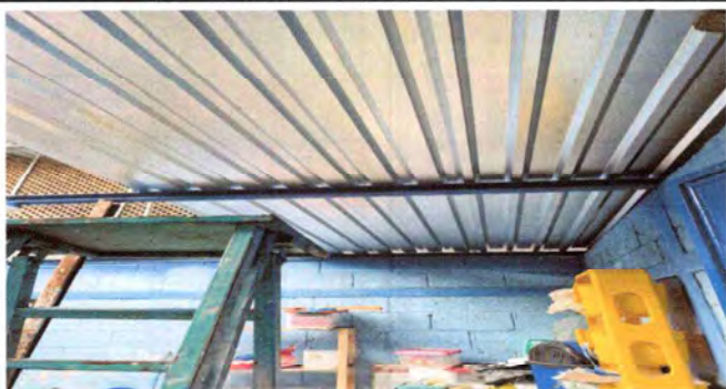
Foto1: CUBIERTA DE LAMINA
