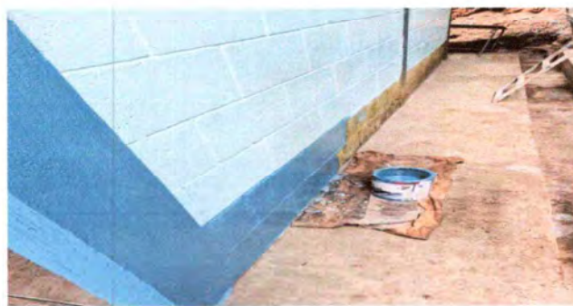
Foto 4: PINTURA DE MUROS INTERIOR Y EXTERIOR
