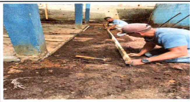
Foto 6: CUNETA DE CONCRETO
