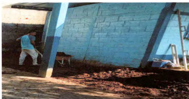
Foto1: LOSA DE PATIO
