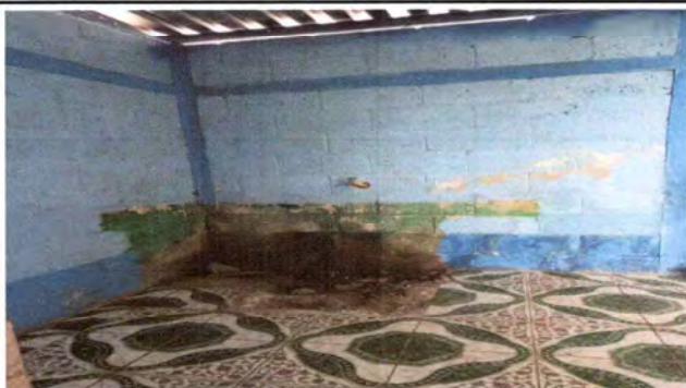
Foto 3: PILA DE COCINA
