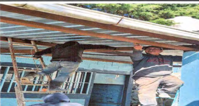
Foto 3: ESTRUCTURA DE TECHO
