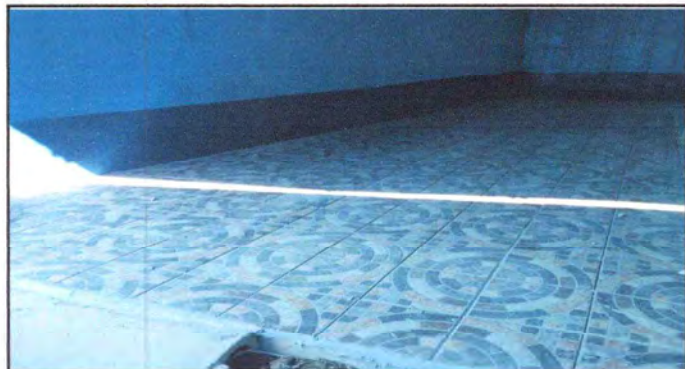
Foto 2: SE INSTALÓ PISO CERAMICO ANTIDESLIZANTE FRENTE AL AULA DE PREPRIMARIA.
