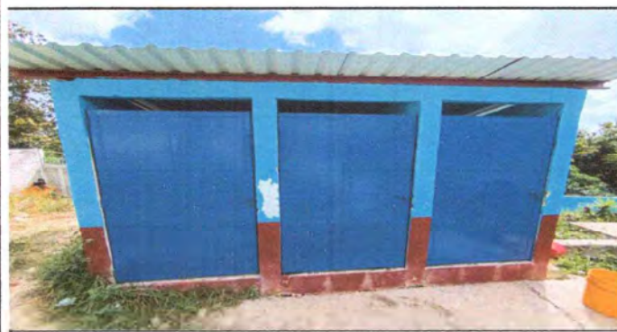
Foto 5: SE SUSTITUYO LAS PUERTAS DE LOS SANITARIOS A UN COSTADO DEL MODULO DE PREPRIMARIA
