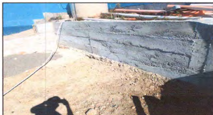
Foto 4: SE REPARÓ LA CIRUCLACIÓN DEL CENTRO EDUCATIVO CON LA CONSTRUCCIÓN DE MURO DE CONTENCIÓN.
