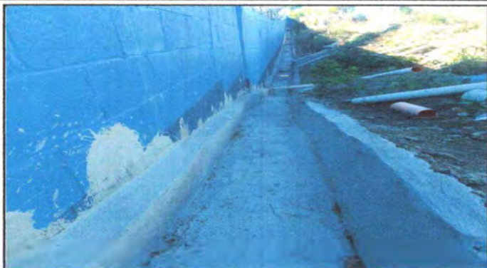
Foto1: SE SUSTITUYÓ LA CUNETA EN EL INTERIOR DE LA CIRCULACIÓN DEL ESTABLECIMIENTO EDUCATIVO.
