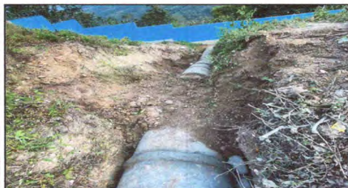
Foto 3: SE INSTALÓ TUBOS DE CEMENTO PARA LA CONDUCCIÓN DE AGUA DE DRENAJE, QUE SE ENCONTRABA EN MAL ESTADO.
