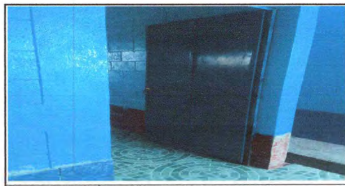
Foto 6: SE EFECTUÓ EL CAMBIO DE CHAPA DEL AULA DE PREPRIMARIA.
