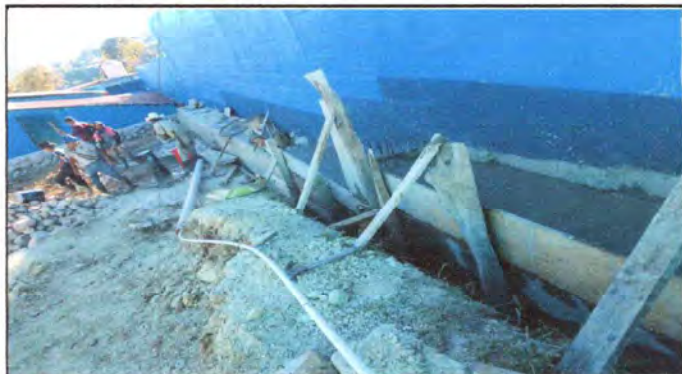
Foto 4: SE ESTABILIZA LA CIRCULACIÓN DEL ESTABLECIMIENTO MEDIANTE LA CONSTRUCCIÓN DEL MURO DE CONTENCIÓN.
