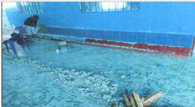
Foto 2: COLOCACIÓN DE PISO ANTIDESLIZANTE FRENTE AL AULA DE PREPRIMARIA, ZOCALO AL AULA.
