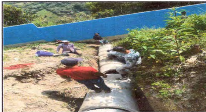
Foto 3: SE INSTALA TUBO DE CEMENTO PARA LA CONDUCCIÓN DEL DRENAJE.
