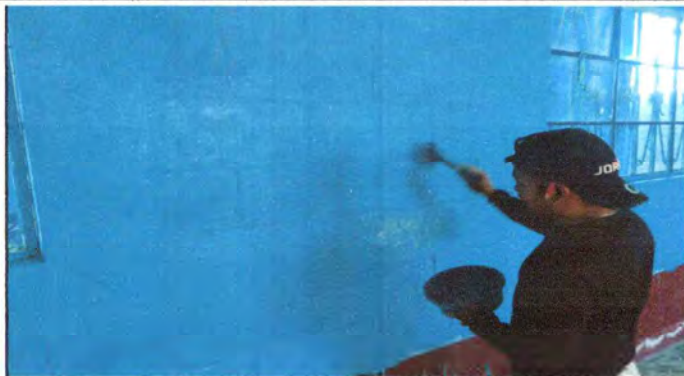
Foto1: APLICACIÓN DE PINTURA BASE ACEITE A DOS MANOS EN EL MURO EXTERIOR Y EXTERIOR DEL MODULO DE PREPRIMARIA
