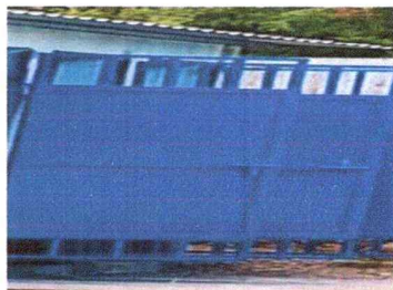
Foto1: Sustitución de Puertas principales de metal en área de baños
