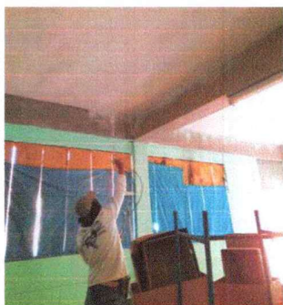
Foto 3: Sustitución de Ventanas en aulas.
