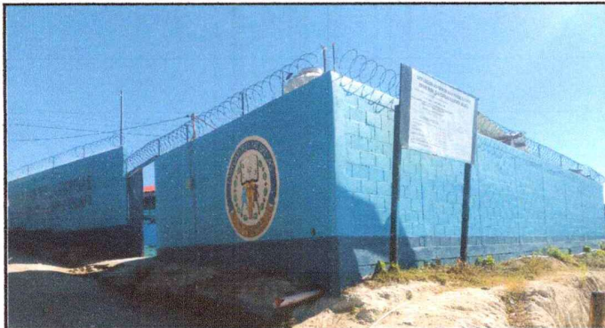
Foto1: APLICACIÓN DE PINTURA DEL CENTRO EDUCATIVO EN EL MURO DE CIRCULACIÓN EN LA PARTE EXTERIOR E INTERIOR.
