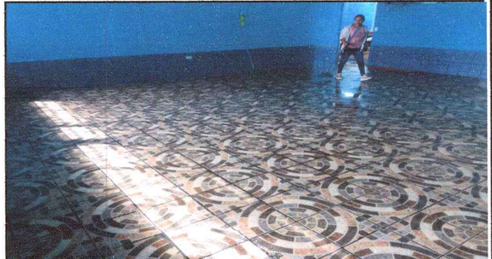
Foto 2: INSTALACIÓN FINALIZADA DE PISO CERAMICO ANTIDESLIZANTE CON ZOCCO.
