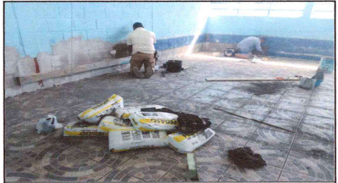
Foto 2: COLOCACIÓN DE PISO ANTIDESLIZANTE, CON ZOCCO.
