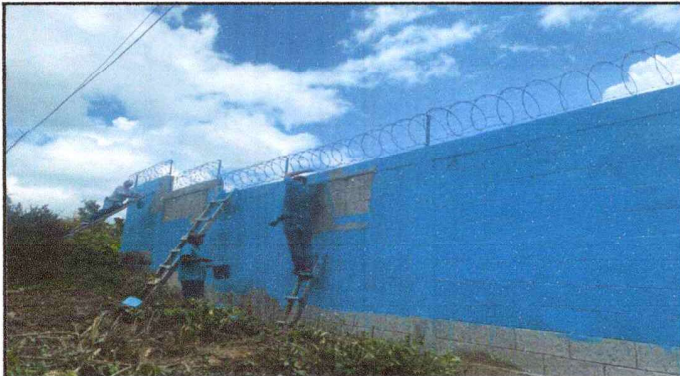
Foto1: APLICACIÓN DE PINTURA BASE ACEITE A DOS MANOS EN EL MURO EXTERIOR DEL CENTRO EDUCATIVO.
