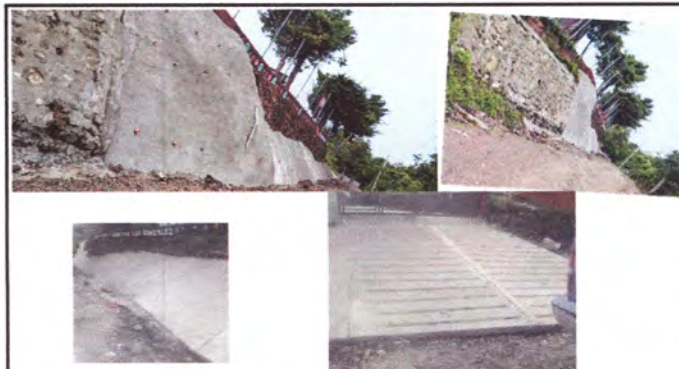
Foto 10: REBESTIMIENTO DE CONCRETO EN TALUD CON ELECTROMALLA Y ENSABIETADO A LA SUPERFICIE DEL TERRENO NATURAL.
