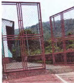
Foto 3: SE LE DARA MANTENIMIENTO AL PORTON DE INGRESO MEDIANTE PINTURA ANTICORROSIVA.
