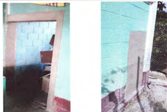
Foto 9: FUNDICION DE COLUMNA, MOCHETA Y TALLADO DE MARCOS DE PUERTA Y AREAS EXTERIORES.
