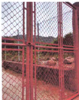
Foto 3: SE LE DARA MANTENIMIENTO AL PORTON DE INGRESO MEDIANTE PINTURA ANTICORROSIVA.
