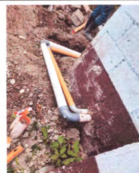
FOTO 2: INSTALACION DE TUBERIA PARA LA INSTALACION DE LOS NUEVOS BAÑOS.
