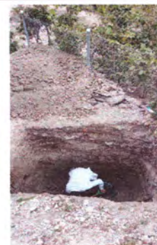
Foto 4: PARA EL CORRECTO FUNCIONAMIENTO DE LOS DOS SANITARIOS NUEVOS ES NECESARIO LA INSTALACION DE UN NUEVO SISTEMA DE DRENAJE YA QUE EL ACTUAL SON BAÑOS SEPTICOS.
