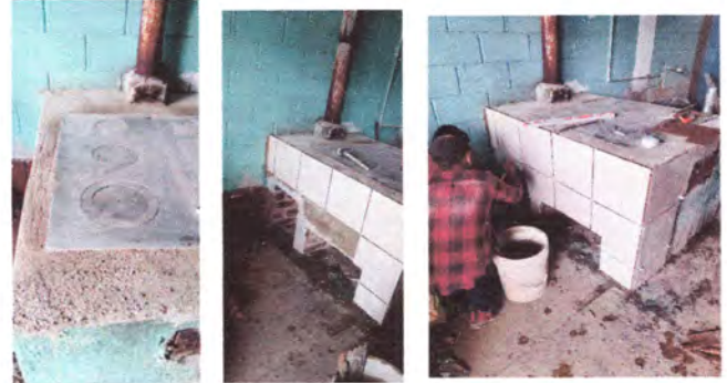
Foto 8: REPARACION (ESTUFAS RURALES, PILAS, CHIMENEAS, ETC.)
