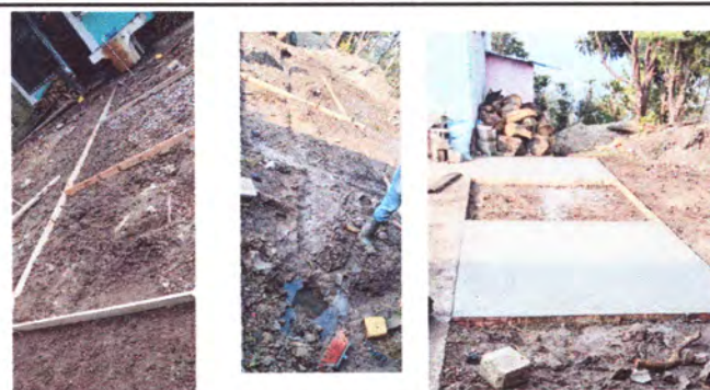
Foto 5: FUNDIR 38.4 METROS CUADRADOS DE LOSA DE PATIO CON UN ESPESOR DE 8 CM, TALLADOS.
