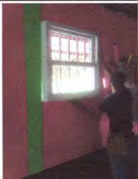
Foto 1: INSTALACION DE VENTANA.
