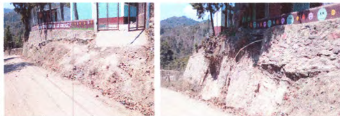
Foto 10: REBESTIMIENTO DE CONCRETO EN TALUD CON ELECTROMALLA Y ENSABIETADO A LA SUPERFICIE DEL TERRENO NATURAL.
