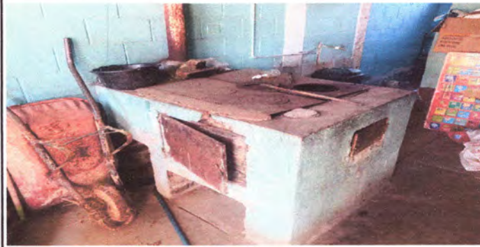
Foto 8: REPARACION (ESTUFAS RURALES, PILAS, CHIMENEAS, ETC.)
