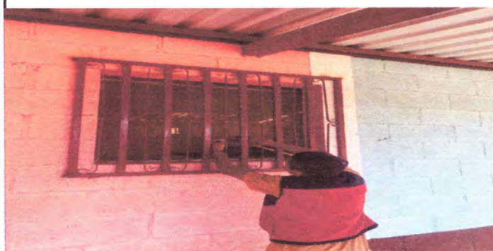
Foto 1: INSTALACION DE UNA VENTANA DE PVC Y PUESTA DE DOS VIDRIOS DE LA VENTARIA PERSIANA DE METAL.
