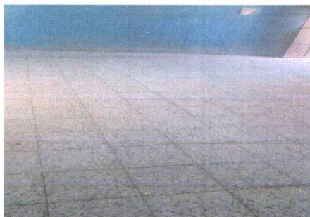
Foto 3: Colocación de piso de granito.
