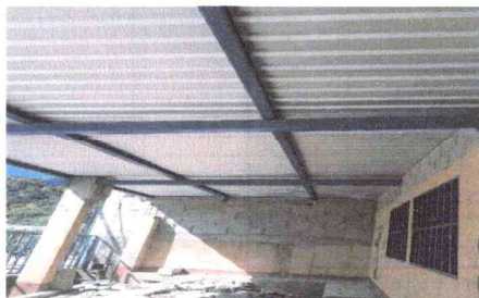
Foto1: Techo de corredor de la Escuela ya ejecutado.
