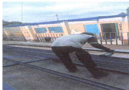
Foto 2: foto pintando el material para el techo.
