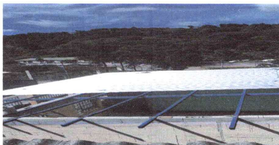
Foto 3: Colocación de techo.
