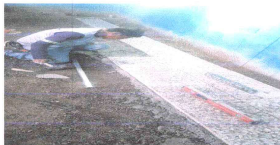
Foto 4: Colocación piso de granito incluyendo base.
