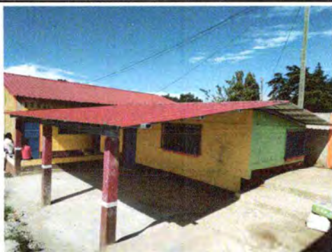
Foto1: CUBIERTA DE LAMINA
