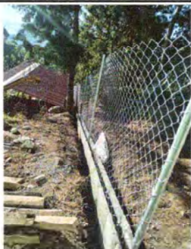
Foto 1: CERCO O MURO PERIMETRAL
