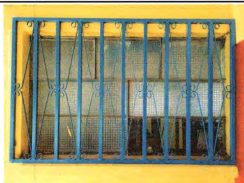
Foto 4: MANTENIMIENTO DE BARANDAS
