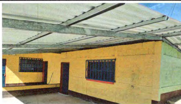
Foto 2: ESTRUCTURA DE TECHO
