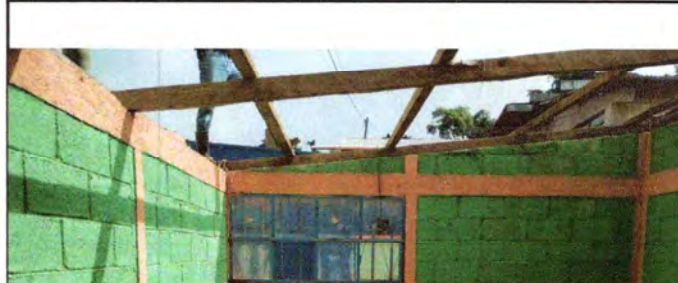
Foto 2: ESTRUCTURA DE TECHO
