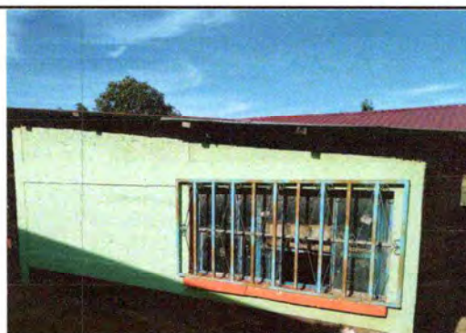
Foto 4: MANTENIMIENTO DE BARANDAS
