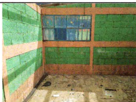
Foto 5: PINTURA DE MURO INTERIOR
