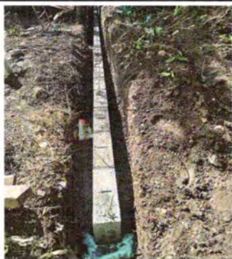
Foto1: CERCO O MURO PERIMETRAL
