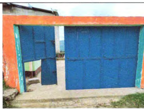
Foto 6: MANTENIMIENTO A PORTONES
