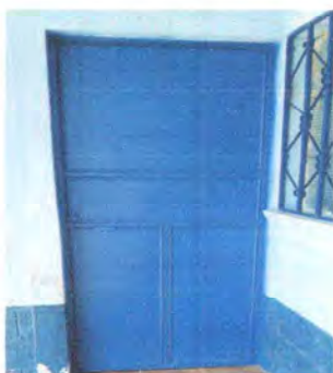
Foto 3: Reparación y mantenimiento de puertas
