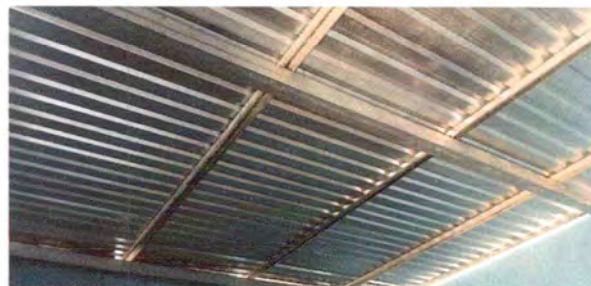
Foto 2: Estructura de techo
