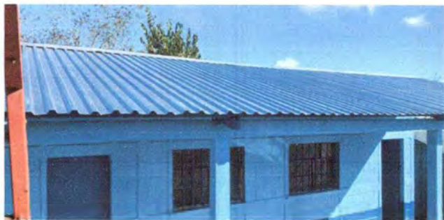
Foto1: Cubierta de lámina
