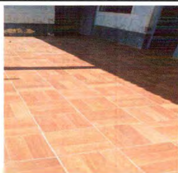
Foto 5: Sustitución de piso
