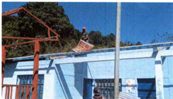
Foto1: Cubierta de lámina
