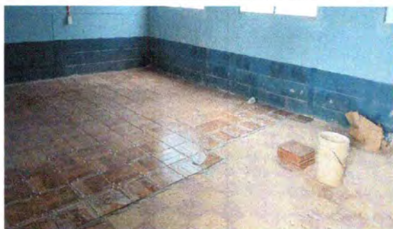
Foto 5: Sustitución de piso
