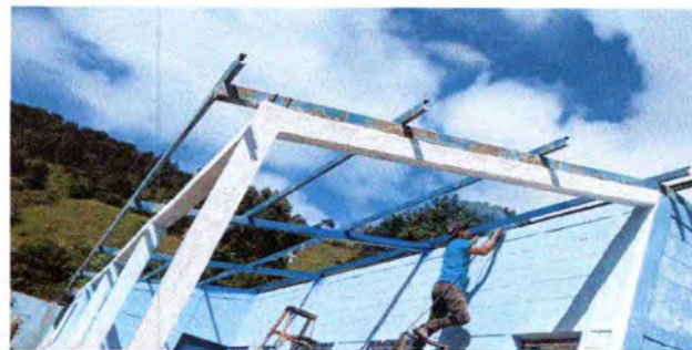
Foto 2: Estructura de techo
