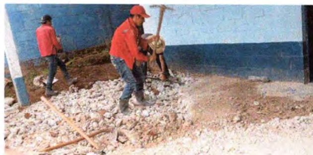
Foto 8: Losa de patio
