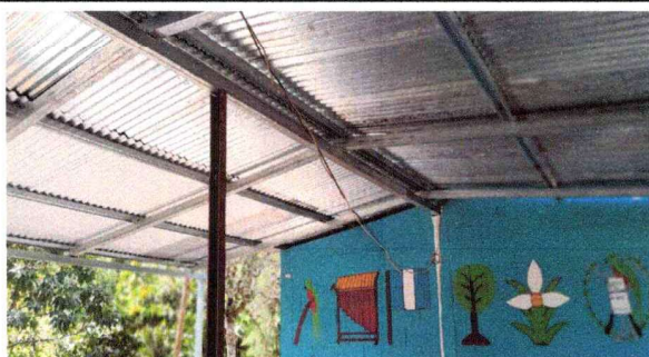
Foto 5: Sustrucción de pintura
