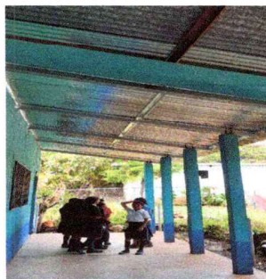
Foto 2: Estructura de techo
