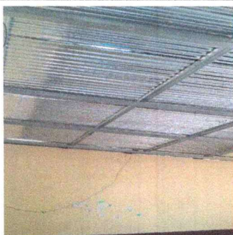
Foto 3: Cubierta de lámina
