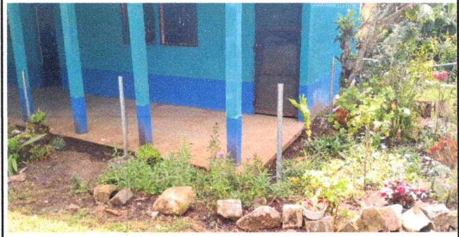
Foto 4: Sustitución de pintura
