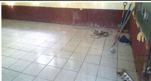
Foto 5: Sustitución de piso cerámico
