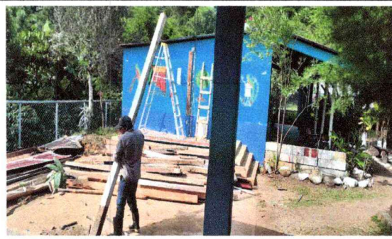
Foto 2: cubierta de lámina
