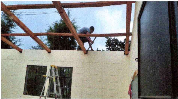
Foto 1: Estructura de techo
