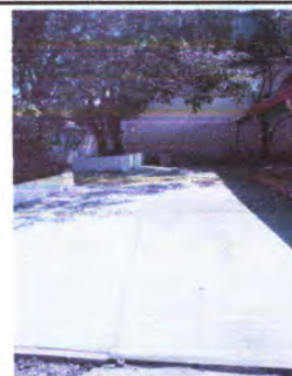
Foto4: fundación de concreto de patio
