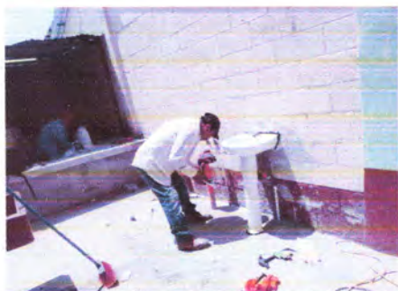
Foto: 5 colocación de lavamanos y pintura de baños
