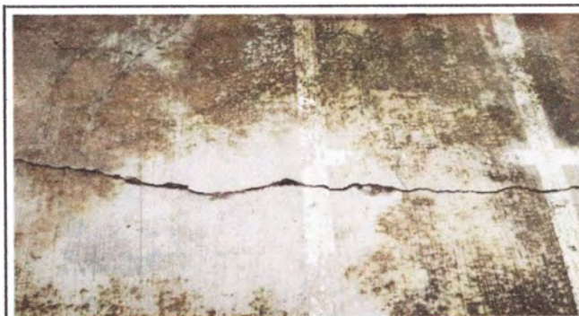
Foto4: fundación de concreto de patio
