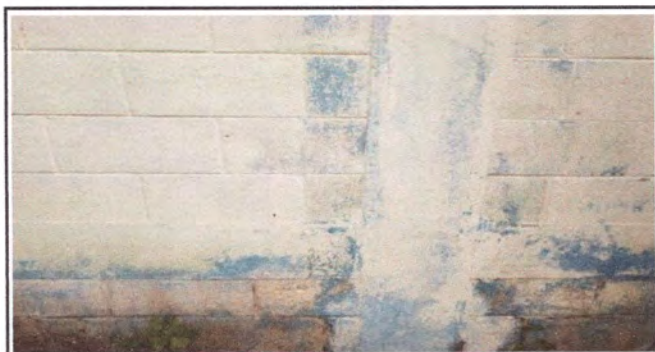
Foto3: pintura de aulas por dentro y por fuera
