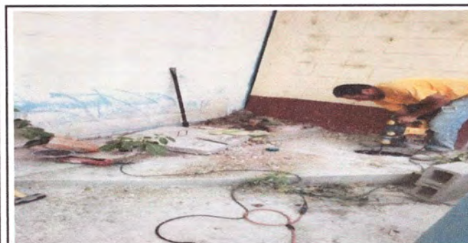
Foto: 5 colocacion de lavamanos y pintura de baño
