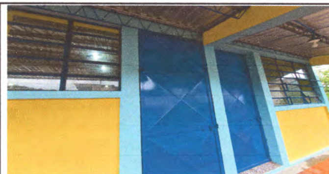
Foto3: puertas reparadas y ventanas
