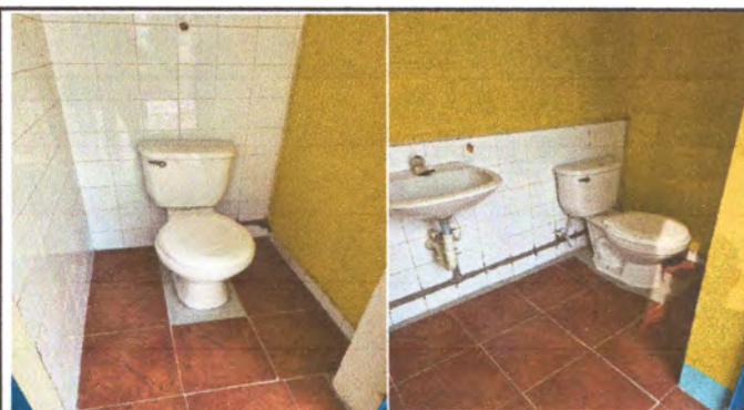
Foto: 5 Servicios Sanitarios, piso y pintura
