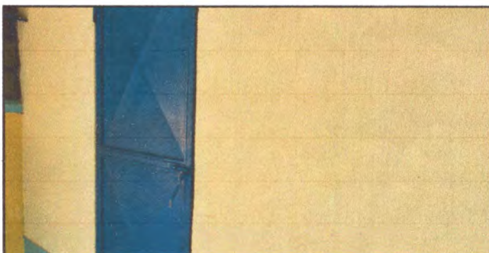
Foto: 6 puertas sanitarios y pintura
