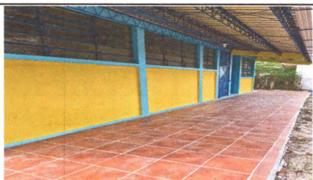
Foto4: pintura exterior, piso corredor
