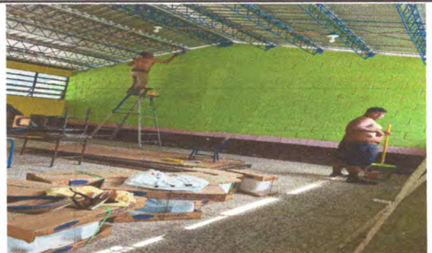
Foto4: Pintura muros interior y exterior
