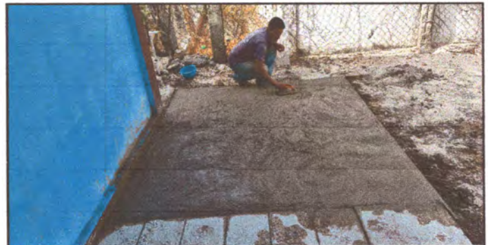
Foto: 6 reparación de torta para instalar piso
