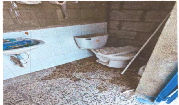
FOTO 2: Reparación de sanitarios
