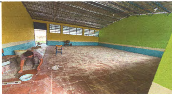
Foto: 5 Colocación de piso
