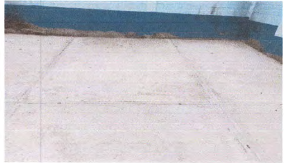
Foto 2: Losa de patio finalizada.
