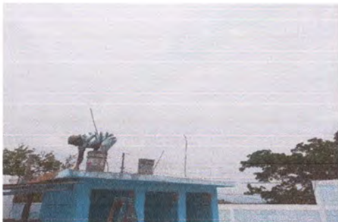
Foto 1: Impermeabilización de losa finalizado.
