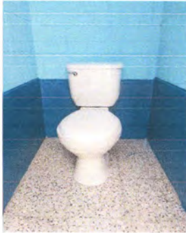
Foto 1: Servicio sanitarios y sus accesorios finalizado.
