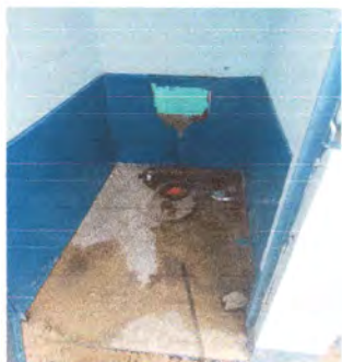
Foto 1: Servicio sanitarios y sus accesorios en proceso.
