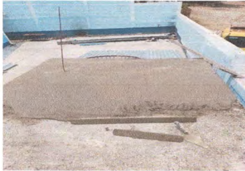
Foto1: Impermeabilización de losa en proceso.
