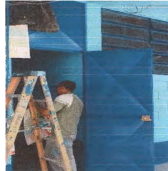
Foto 2: Puertas en proceso.
