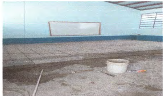
Foto 4: Piso en proceso.
