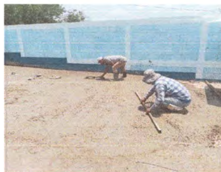
Foto 2: Losa de patio en proceso.
