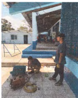
Foto 3: Reparación de sistema eléctrico en proceso.
