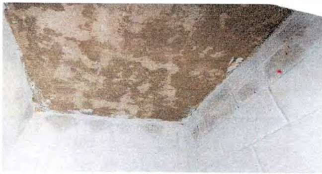
Foto1: Losa de techo de sanitarios en mal estado, por filtración de agua.
