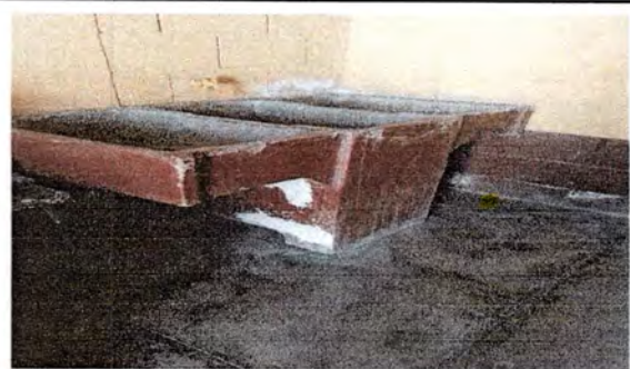
Foto: 6 Pila en mal estado con grietas y fuga de agua.
