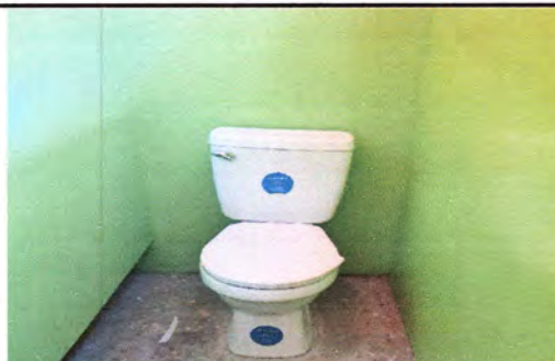
Foto: 6: Sanitarios destruidos. Sustitución e instalación por nuevos servicios.
