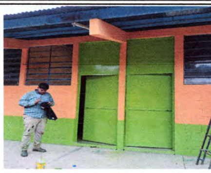
FOTO 2: Puertas oxidadas y corrosionadas. Ya pintadas y restaurada en buen estado.
