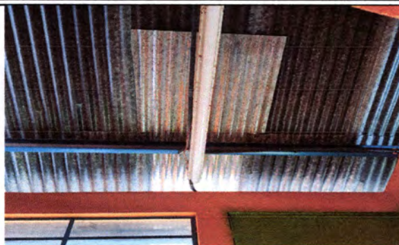
Foto1: Lámina en mal estado con agujeros. Se restauró por lamina nueva.
