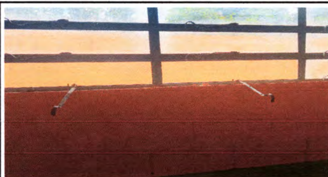
Foto3: Vidrios rotos, flojos y sucios de ventanales. Yá Reparados, limpiados y se sustituyeron los rotos.
