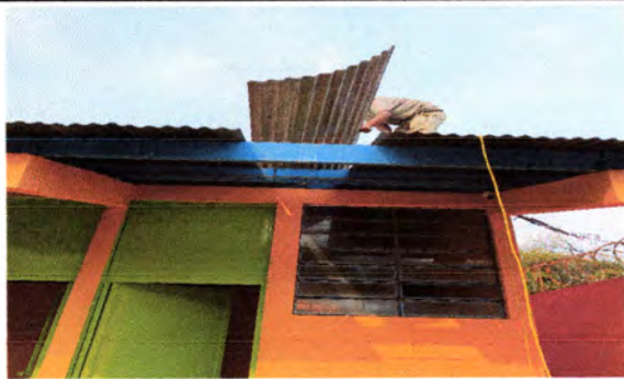
Foto1: Sustitución de lámina en mal estado con agujeros.
