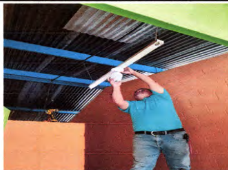
FOTO 8: Sustitución y reparación de Impara squemadas, en mal estado.
