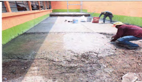
FOTO 10: Reparación de losa de patio con grietas y quebraduras.
