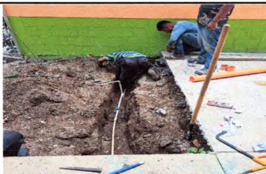
FOTO 9: Desobstrucción de red de drenaje y agua potable.
