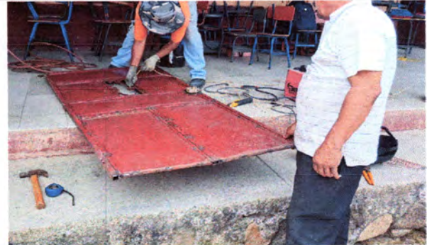
FOTO 2: Reparación de puertas oxidadas y corrosionadas.
