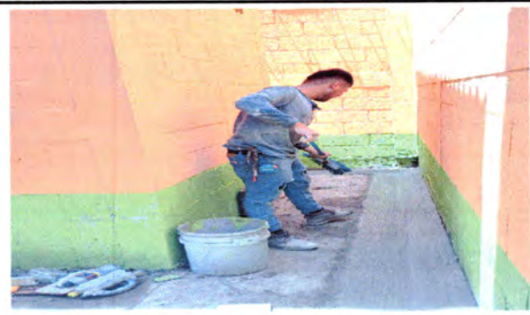
Foto4: Reparación de cunetas obstruidas y en mal estado.
