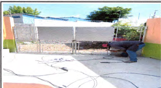
FOTO 7: Reparación de portón de entrada corrosionado.
