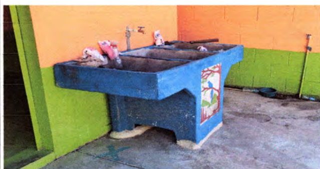
FOTO 9: Red de drenaje y agua potable reparado.
