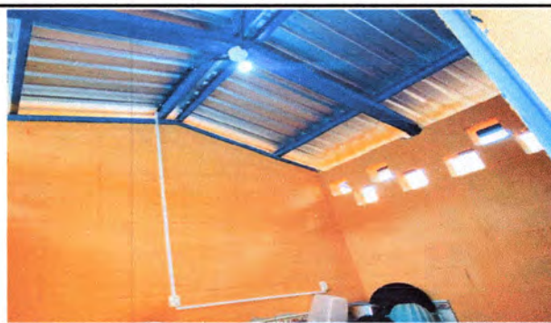
FOTO 8: Lámparas y sistema eléctrico restaurado.
