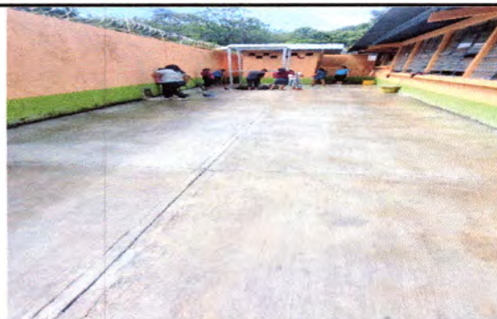
FOTO 10: Losa de patio reparada.
